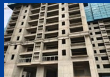
全现浇混凝土外墙
